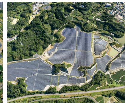
第2太陽光発電所
