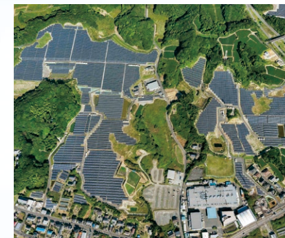
第1太陽光発電所
